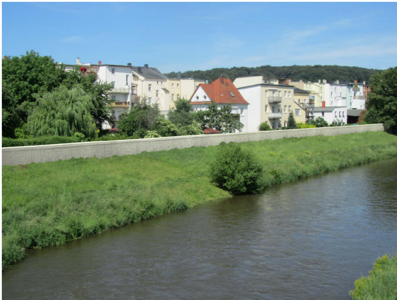
Bild 01: Ansicht vom Schlachthofsteg in Richtung Nordwesten (stromabwärts) auf den Abschnitt 6 der Trasse
